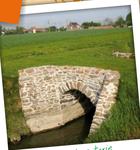
Ponceau de la Câtérie à Rosult
