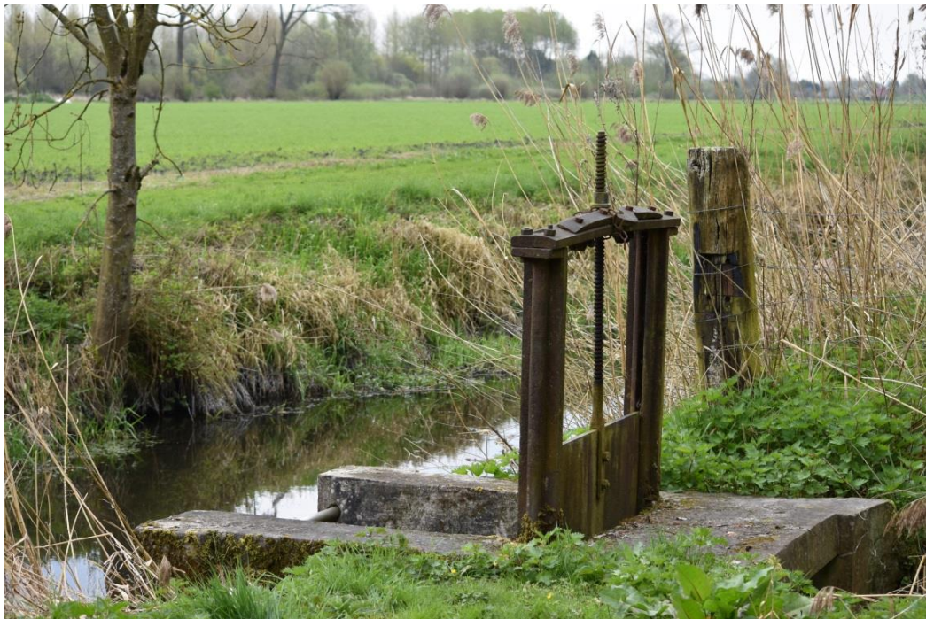
Figure 10 : Vantelle assurant la gestion des eaux du marais de Fenain
