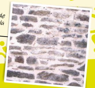
**\*Joint tiré à la pointe :** joint dont le milieu est marqué par une fine incision rectiligne, généralement faite avec la pointe de la truelle. Ces incisions donnent une impression de régularité sur un appareil à joints incertains.
