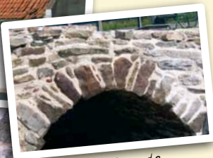
restauration de joints à la chaux sur un ponceau
