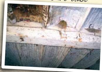
voûtains badigeonnés de chaux dans une étable
